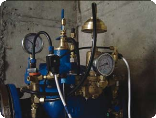
Figura 5. Fotografii care prezintă multi punctul PRV instalat în DMA123
